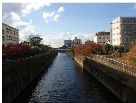
図-1.17 住吉川水門上流側
