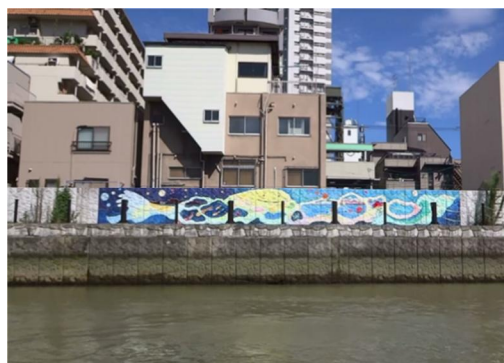
図-1.14 木津川ウォールペインティング （河川側から作品を鑑賞できる）
