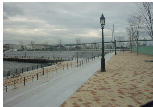
図-1.11 安治川 あじがわ スーパー堤防区間
