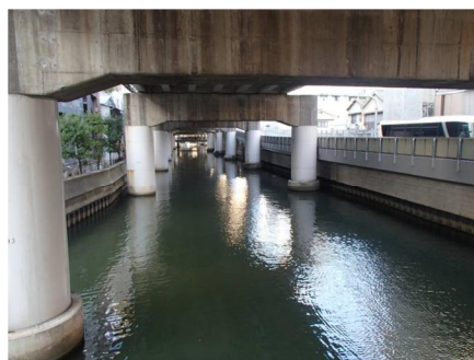
図-1.20 上大和橋下流
