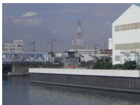
図-1.17 住吉川水門下流側
