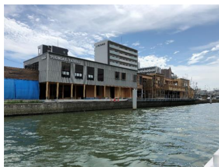
図-1.16 尻無川賑わい空間整備箇所
