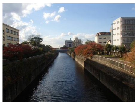
図-1.18 住吉川水門上流側
