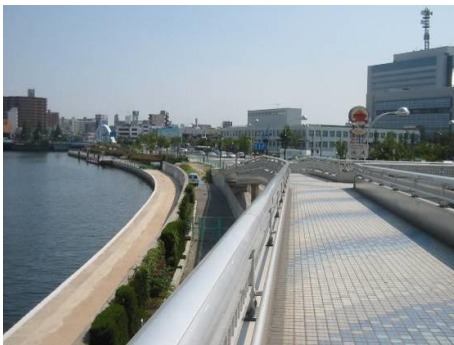
図-1.12 木津川・尻無川スーパー堤防区間
