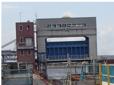
図-1.23 正蓮寺川水門
