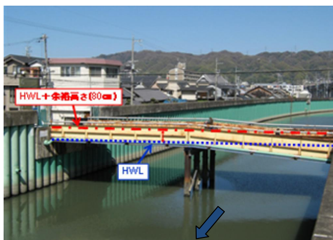
図 2.3 三箇大橋の現況
