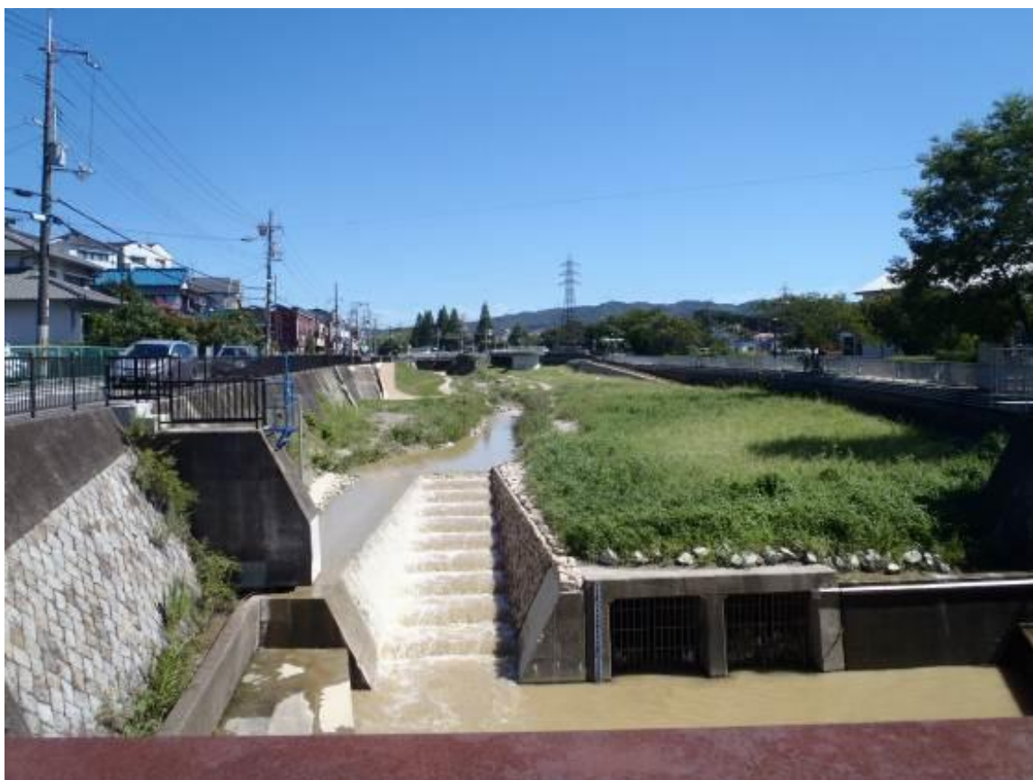
図 2.14 平成 25 年 6 月に完成した川勝水辺ひろば(寝屋川市川勝町)
