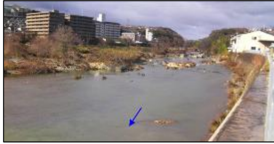
写真② 大阪府管理区間下流端付近
