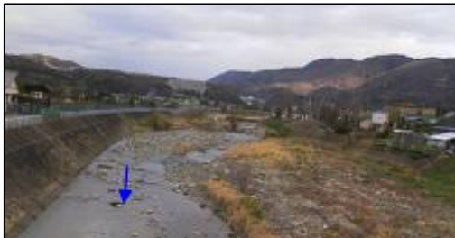
写真① 下流部（中河原橋 なかがわら 上流部）
