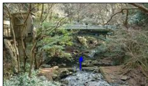
写真② 上流部（大門橋下流部）
