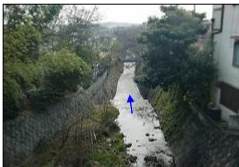
写真① 石澄川（石澄川橋下流部）
