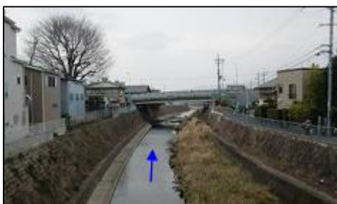
写真① 下流部（天神小橋下流部）
