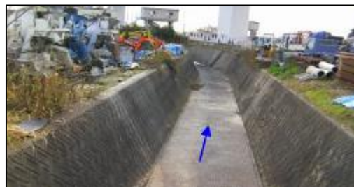
写真① 神田排水樋門上流
