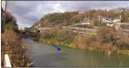
写真① 大阪府管理区間上流端付近
