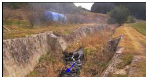
写真③ 石田川（ぬかぐら橋上流部）
