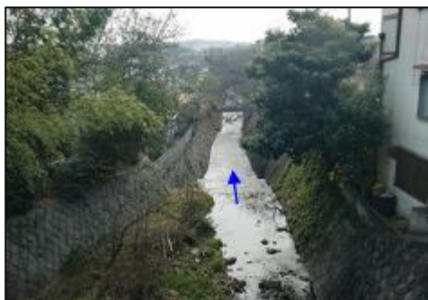
写真① 石澄川（石澄川橋下流部）
