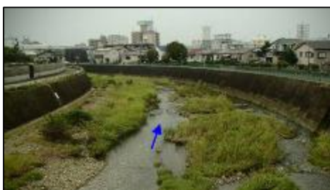
写真① 下流部（箕輪小橋下流部）
