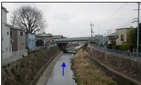
写真① 下流部（天神小橋下流部）
