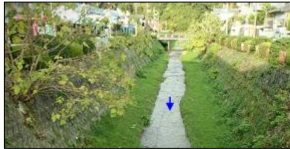
写真① ときわ大橋上流部
