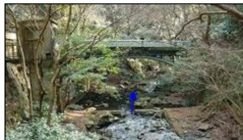
写真② 上流部（大門橋下流部）
