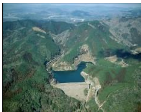
写真③ 箕面川ダム
