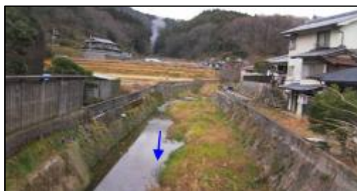
写真③ 上流部（城之越橋 しろのこし 上流部）
