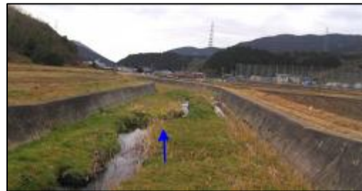
写真② 切畑川（三界橋下流部）
