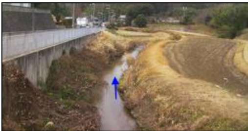
写真① 木代川（新木代橋下流部）
