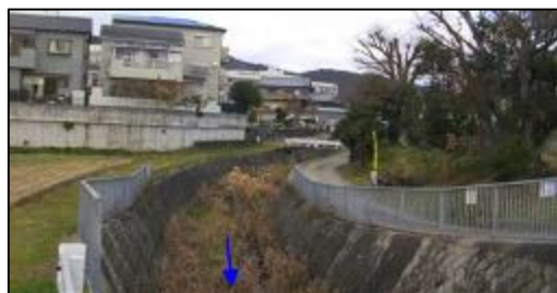
写真① 箕面鍋田川（三平橋上流部）
