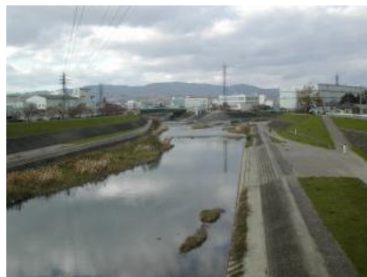
安威川 茨木市西河原 茨木川合流点
