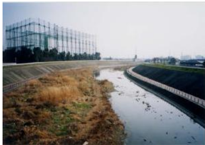
安威川 茨木市 山科橋下流
