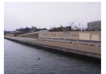
写真-2.4.4 佃防災船着場
