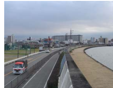
写真-2.4.1 防潮堤状況 (1)
