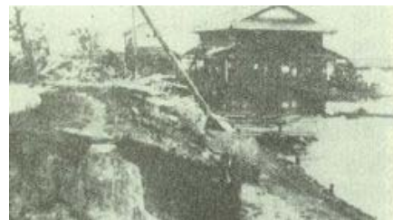
室戸台風で被災したが流出をまめがれた民家
