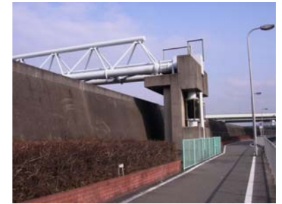
写真-2.4.2 防潮堤状況 (2)
