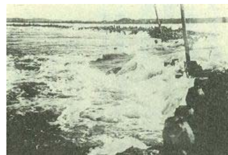
大塚の堤防決壊箇所（大正6年）
