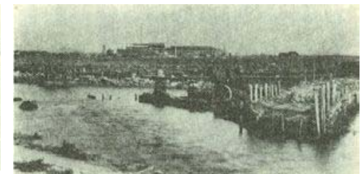
室戸台風により破壊された西島町中堤防
