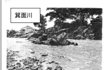
箕面川右岸の崩壊で流失した城上町の民家 (池田市豊島北 1 丁目)
