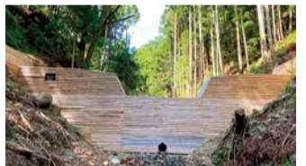
危険渓流の流木対策の様子
