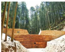
流木対策の様子
