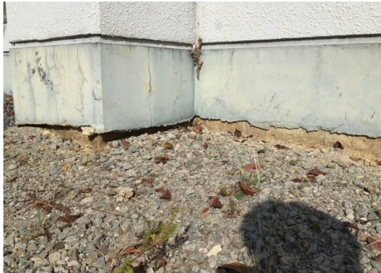
玄関右側壁面にクラック(複数箇所)
