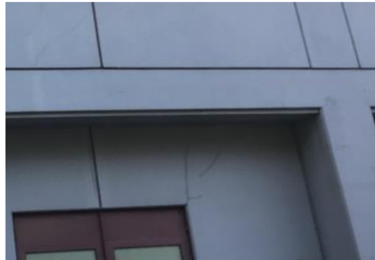
玄関右側壁面にクラック(複数箇所)
