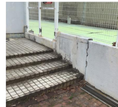
プールとの仕切り擁壁の沈下 階段踊り場の窓が開閉不可 その他、建具の不具合箇所多数あり
