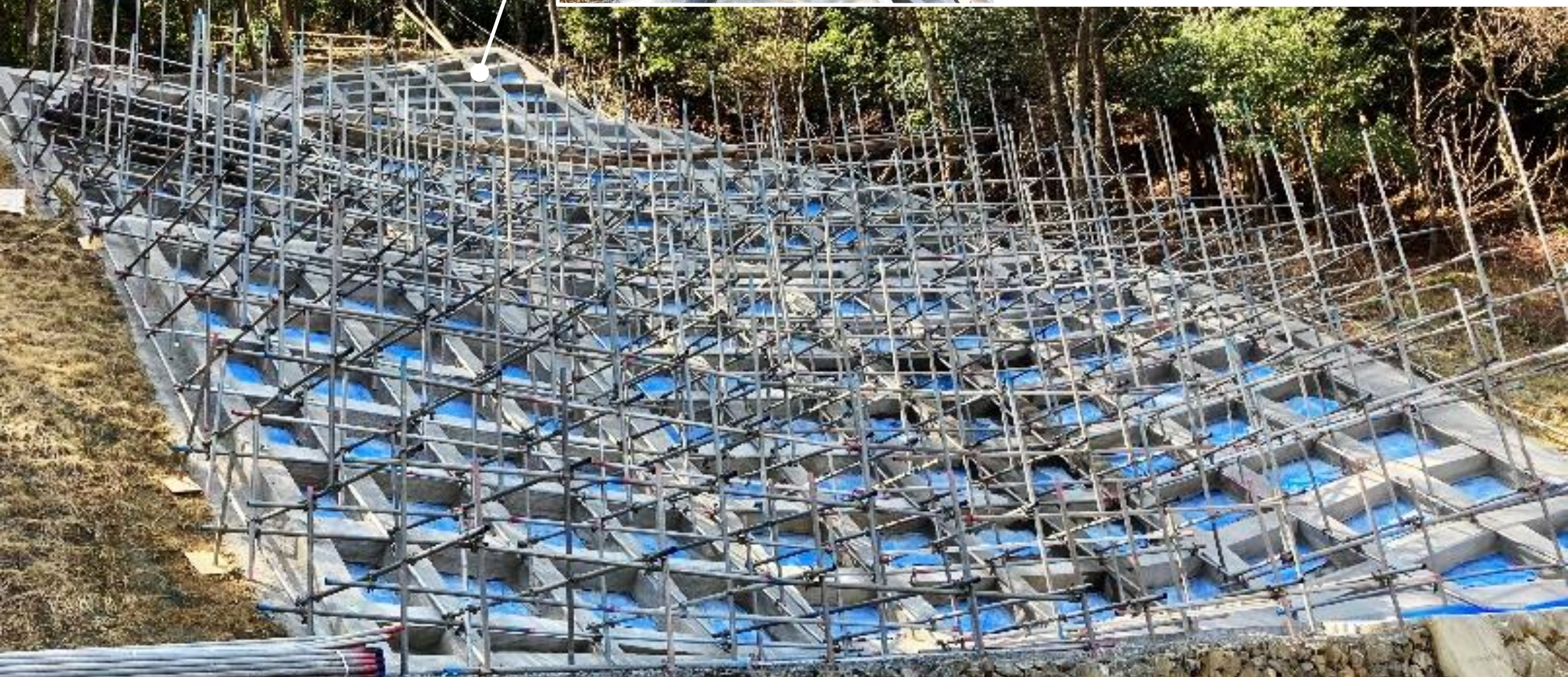
鉄筋挿入工のための足場
