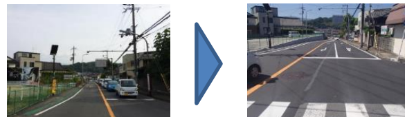
交差点改良事例 (右折レーンの設置)
