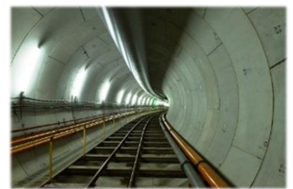
本体工事(下水道増補幹線)
