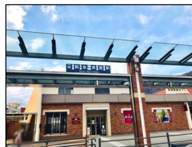
公共交通利用促進のためにワークショップ形式で再整備した駅前広場 (例: 箕面駅)
