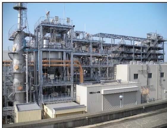
省エネ機器導入例(中央水みらいセンター) 「過給式焼却炉の導入により電力使用量を大幅削減」
