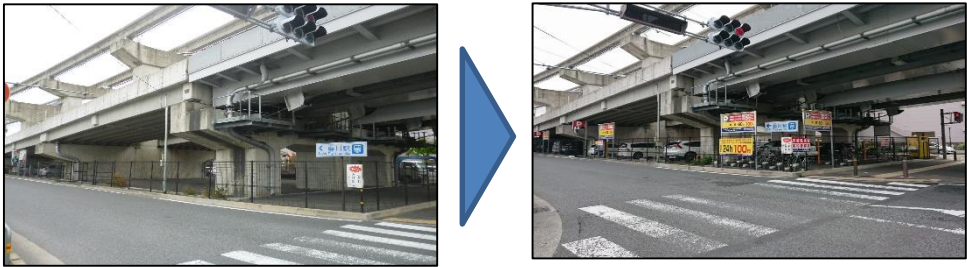
茨木摂津線高架下の有効活用事例 (茨木市)
