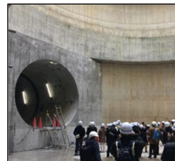
寝屋川北部地下河川 (守口立坑)
