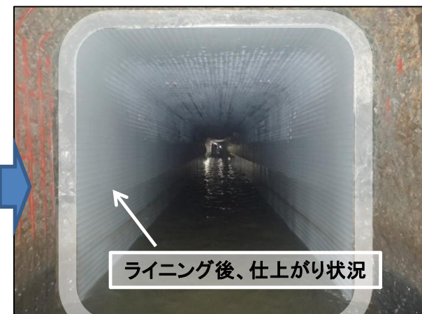
下水管渠内の完了状況
