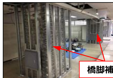
鉄道駅の耐震補強 (橋脚補強)
