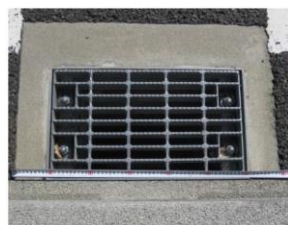
【自転車の通行に配慮したグレーチング蓋への交換】
