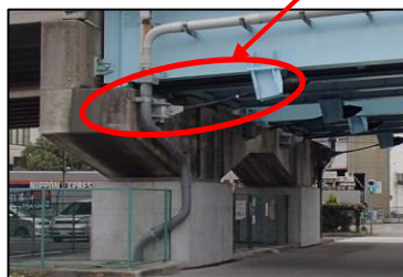
道路橋の耐震補強 (落橋防止対策・橋脚補強)
