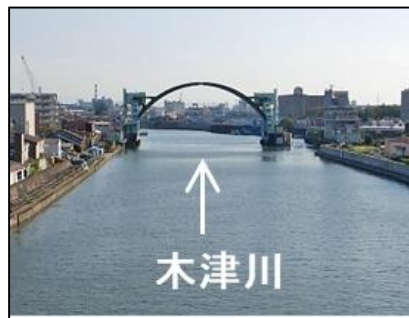
(現在の木津川水門)
