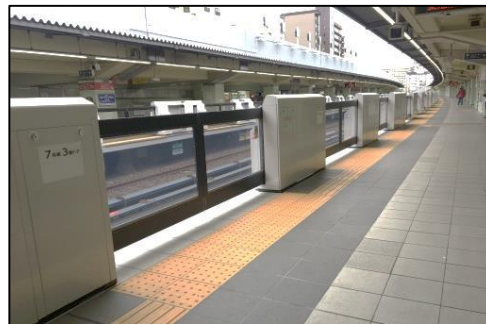
可動式ホーム柵の設置(扉式)
