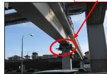
歩道橋の耐震補強 (落橋防止対策)
