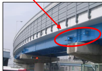
道路橋の耐震補強 (落橋防止対策)
