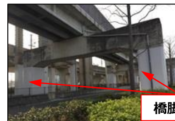
鉄道と道路が並走する箇所の耐震補強 (橋脚補強)
