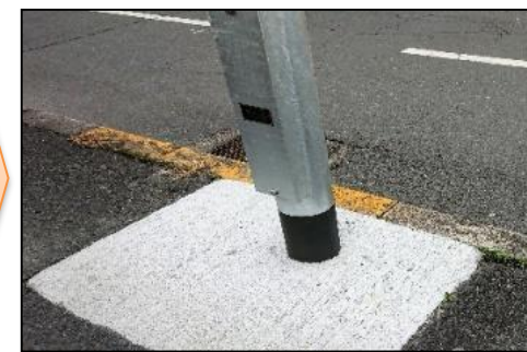
道路照明灯の更新
