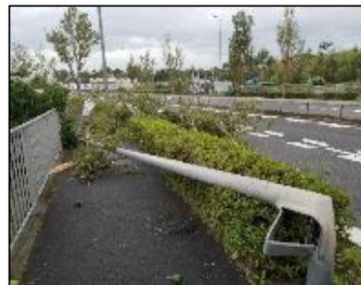
道路照明灯の倒壊(H30台風21号)
