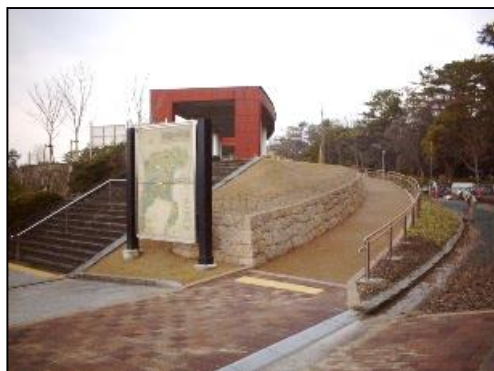
スロープの設置
