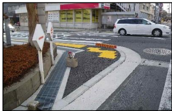
既存道路における 段差、勾配の改善例
