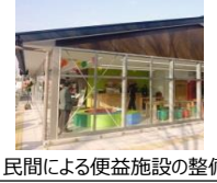
民間による便益施設の整備
