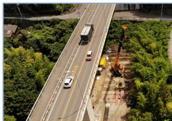
国道170号 (4車線化)
