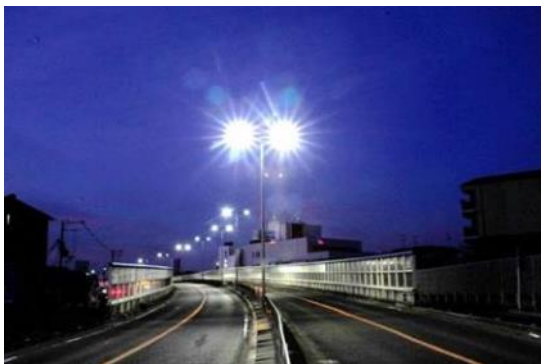
国道170号 (羽曳野市内)
