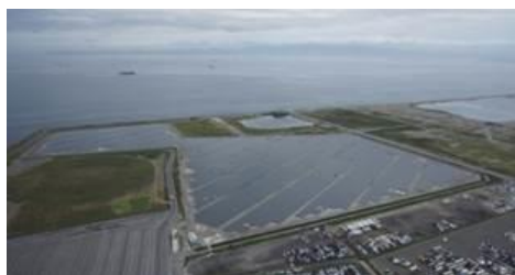
泉大津大規模太陽光発電施設
