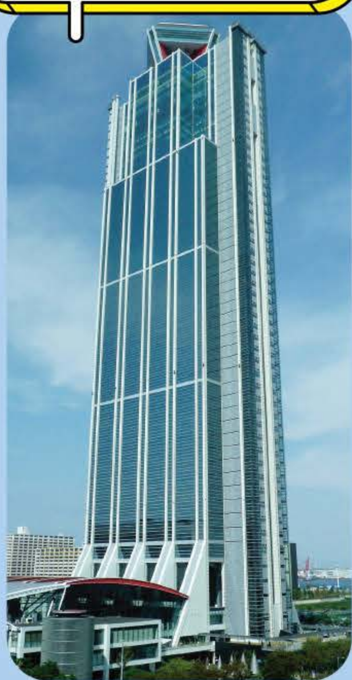
大阪府庁 (咲洲庁舎)
