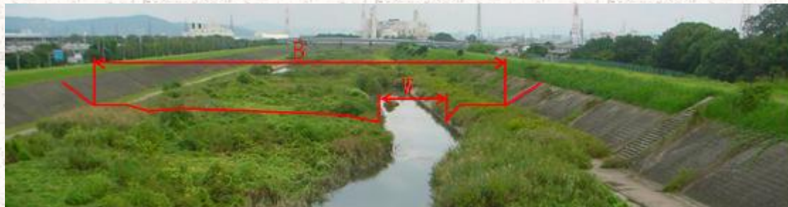
区間B: 宮鳥橋(上流側)
