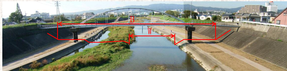
区間C: 千歳橋(上流側)
