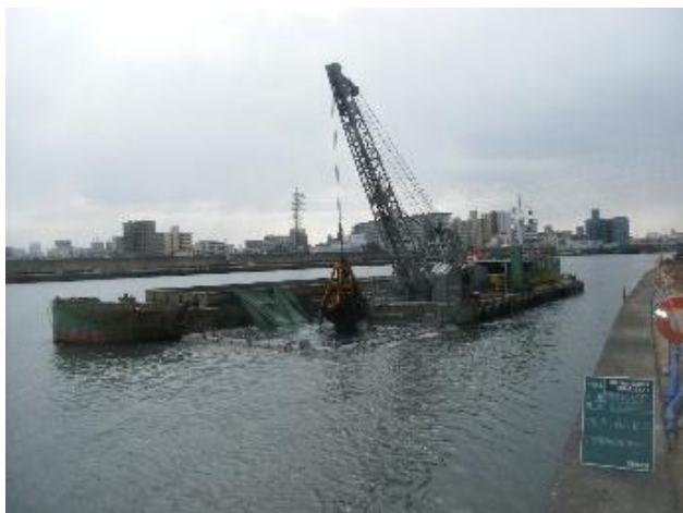
神崎川河床掘削工事
