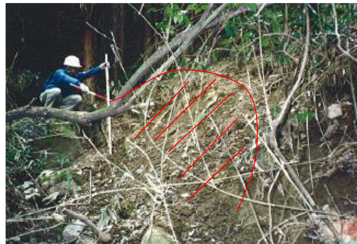
山腹崩壊状況
