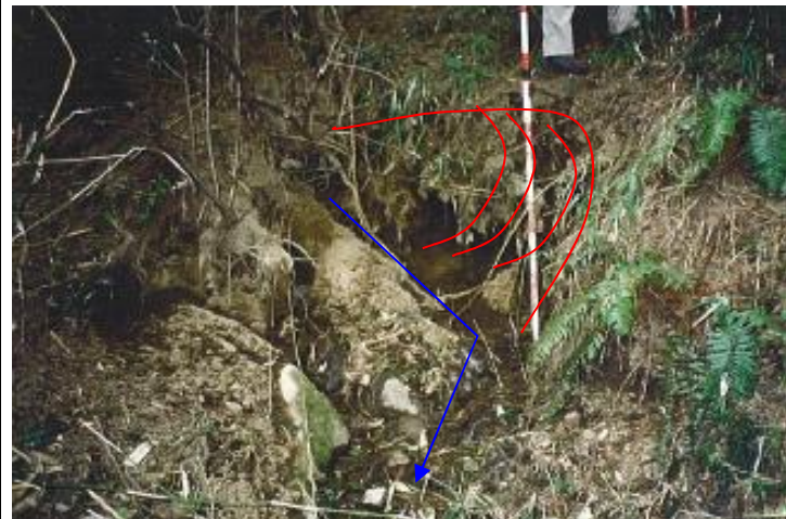
山腹崩壊状況
