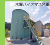
木質バイオマス発電所
