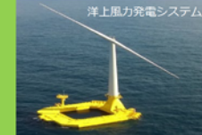
洋上風力発電システム
