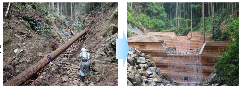
治山ダムを 階段状に配置 (土石流対策)
