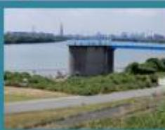
取水塔は、淀川の水を取り入れ、浄水場へ供給するための施設です。私たちが、淀川の水で暮らしていることを感じさせてくれます。
