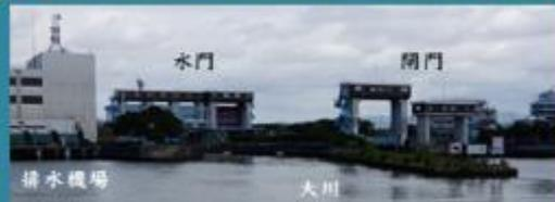
普段、淀川の水は水門から大川に流れています。高潮や洪水の際は大川の水位が上がるため、排水機場より大堰より下流に排水する仕組みになっています。淀川舟運の定期航路の見所の1つです。
