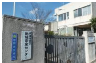
長瀬南校区地域安全センター（東大阪市）
