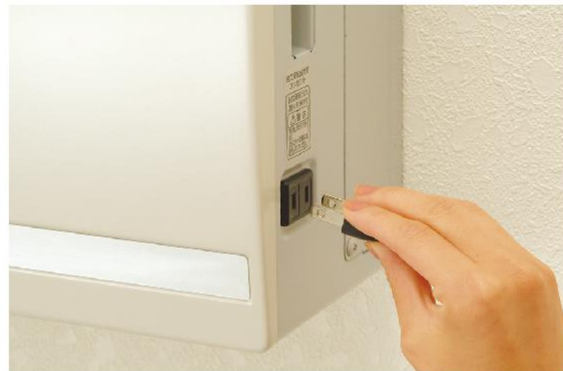
非常用コンセント (屋内設置パワーコンディショナの例)
