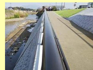
西除川アンダーパス (R2.3月完成)
