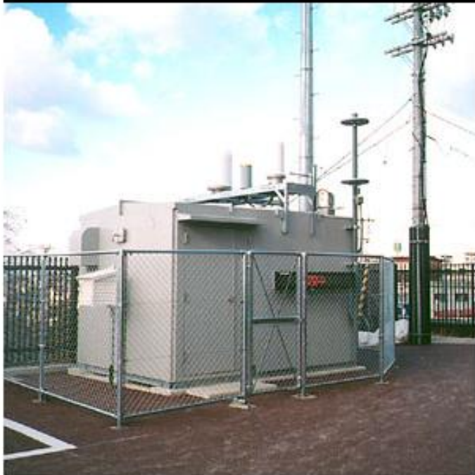
大阪府熊取オフサイトセンター観測データ
