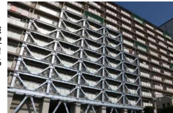
建物の耐震補強の様子
