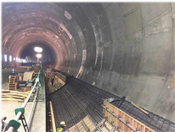
▲設備室の鉄筋・型枠組立状況
