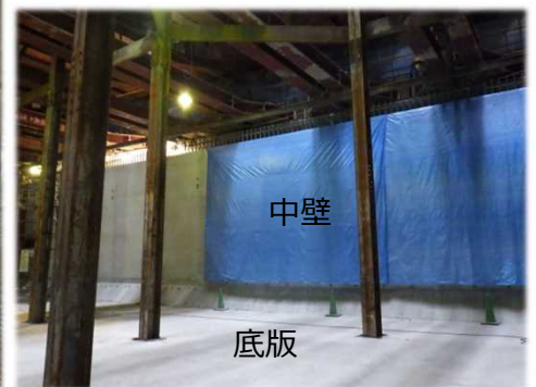
▼底板・中壁構築状況
