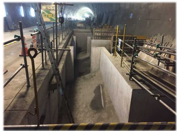
▲すべり台室の構築状況
