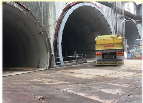
▲トンネル本体完成 (No.4立坑部)
