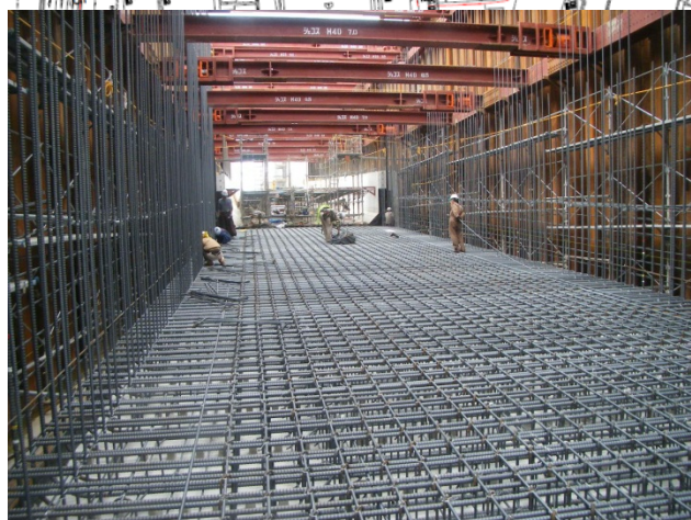
鉄筋組立状況 (オフランプ底版部)
