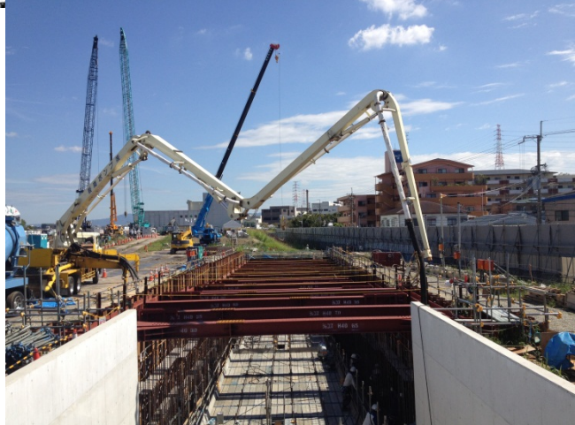
コンクリート打設状況 (オフランプ壁部)
