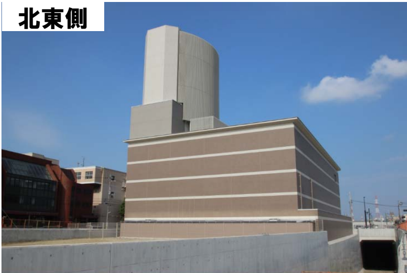
換気ファン室
