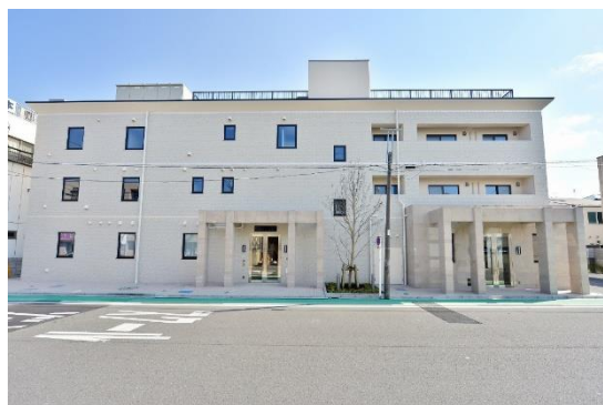
川崎自立会・外観
