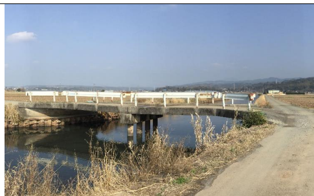
443-3003 農道橋 現況 (延長 17.4m)
