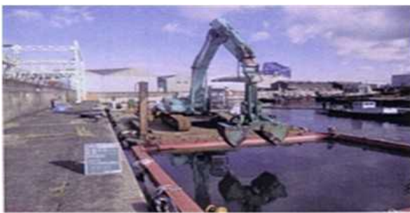
浚渫船による汚染底質の除去
