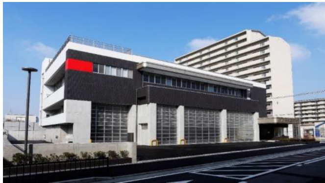
建替事業により創出した用地に消防署を建設した事例（門真千石西町住宅・門真市）
