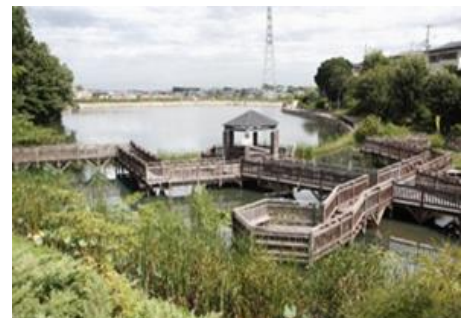
[長池オアシスの親水施設（熊取町）]
