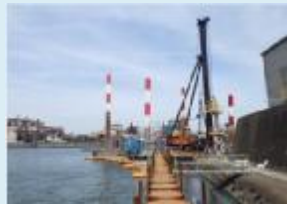
防潮堤補強工事
