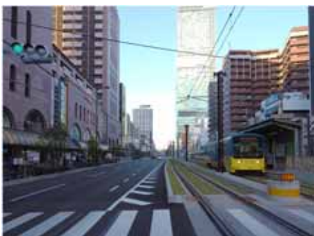
写真-6 阪堺電気軌道上町線の軌道敷の芝生化（H30.3）
