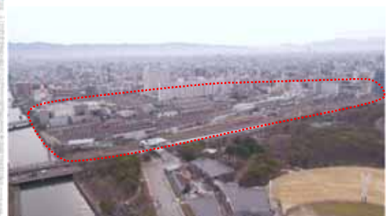
写真-5 大阪城東部地区
