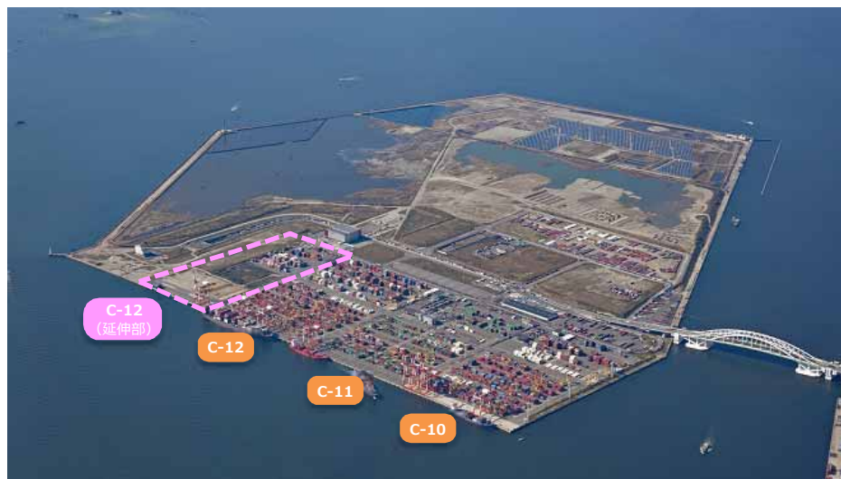
図-1 夢洲コンテナターミナル
