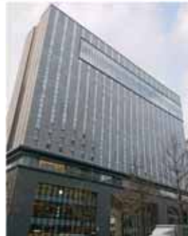
南御堂ビル 写真-5 御堂筋沿道の開発状況
