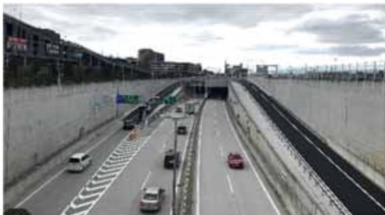
写真-1 大和川線の状況
