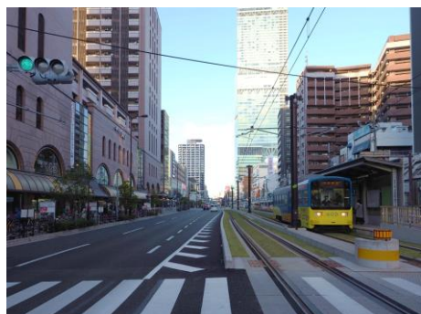
写真-5 阪堺電気軌道上町線の軌道敷の芝生化（H30.3）
