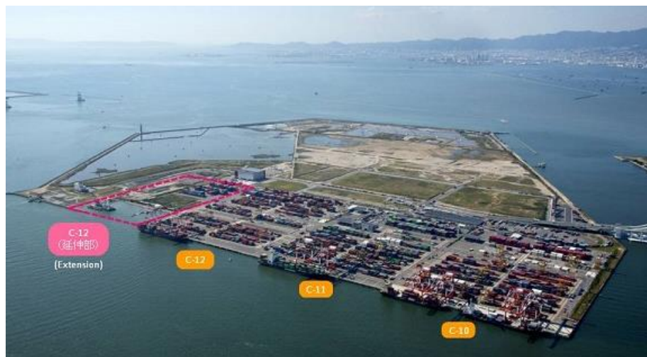
図-1 夢洲コンテナターミナル
