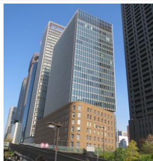
写真-3 ダイビル本館の建替
