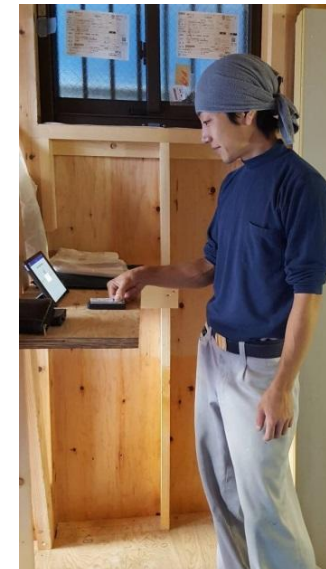
戸建住宅現場の屋内にiPadを設置
