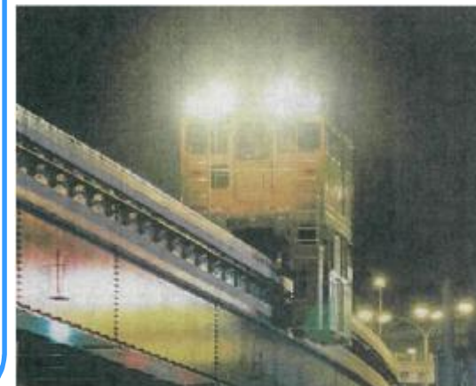
地震発生後の 工作車による 点検の様子
