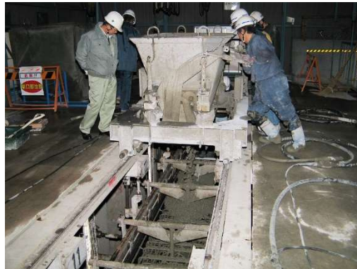
型枠へのコンクリート打込み
