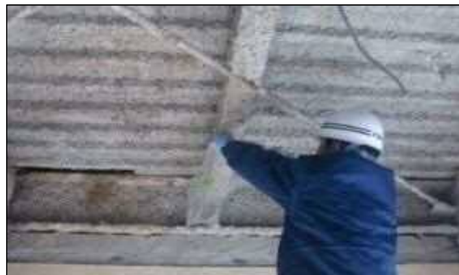
解体工事における石綿の立入調査
