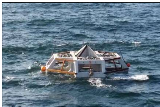
水質改善のために設置された攪拌ブロック
