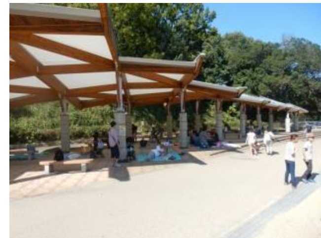
水辺の里休憩所
