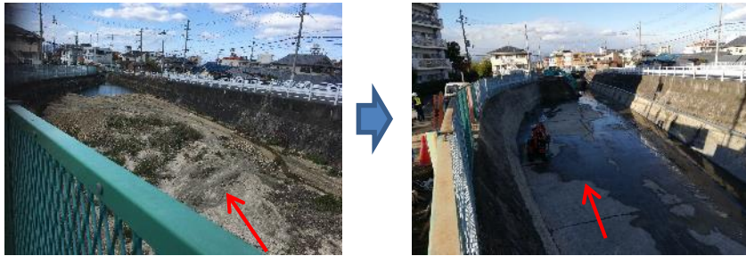
傍示川（砂溜工）
