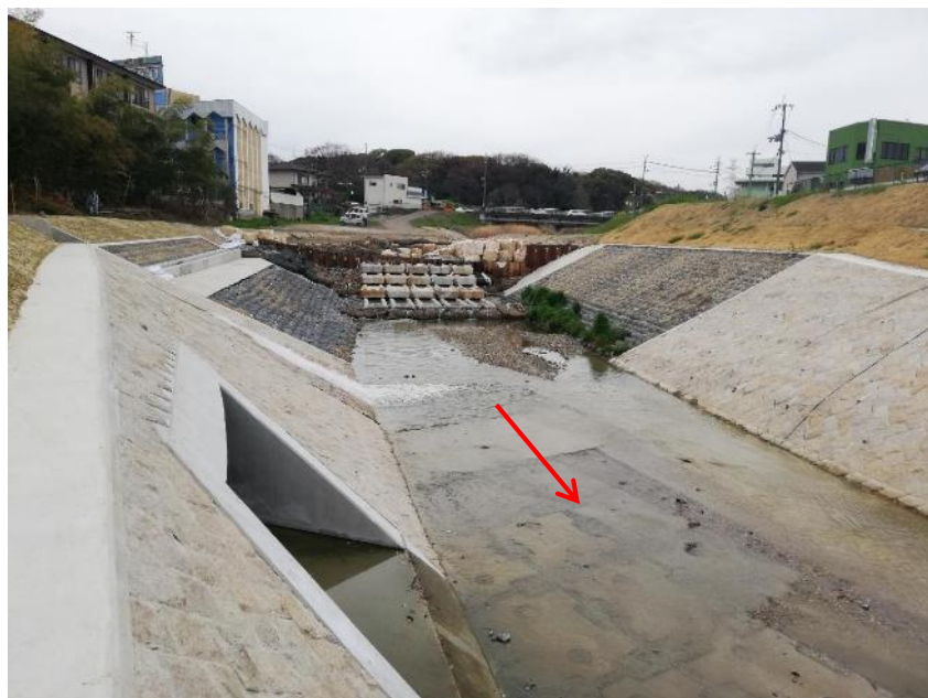
穂谷川改修工事（80mm対策）施工中
