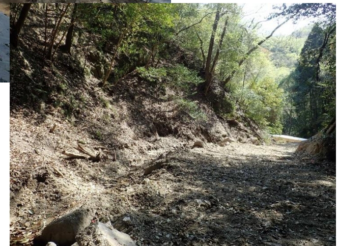
②流木の危険がある木を伐採
