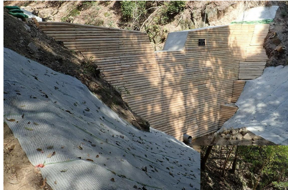
①治山ダム全景
