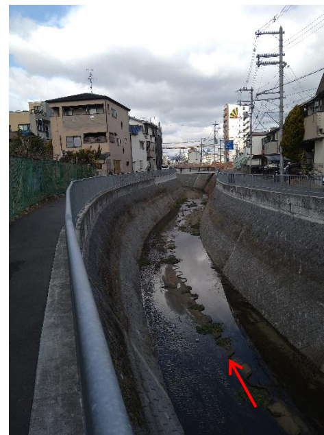
前川改修工事（65mm対策）完成
