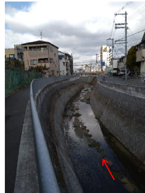
前川改修工事（65mm対策）完成
