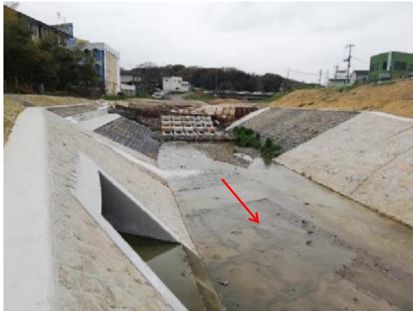
穂谷川改修工事（80mm対策）施工中
