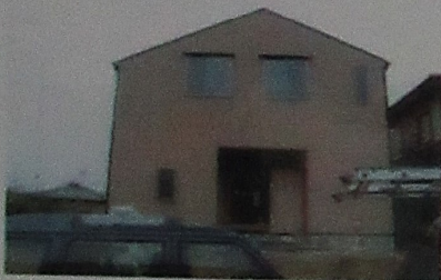
完了検査時の全景
