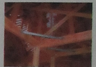
梁、桁を金物等で緊結・・・OK
