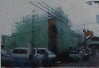
中間検査時の全景
