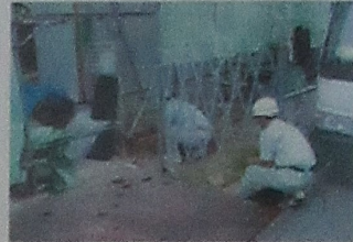
図面と建物の配置を照合・・・OK
