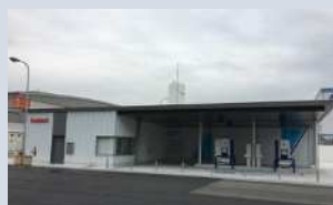
水素ガスヤード全景
