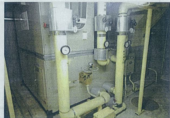
M 16 地下1階 AC-2/エアハンドリングユニット外景 空調設備 機械室
