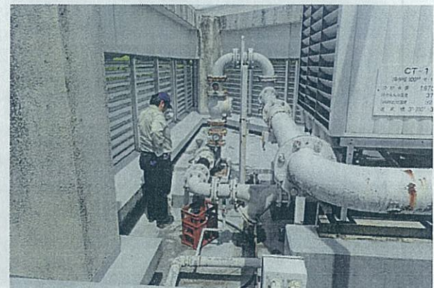
M 05 2階屋上階 空調熱源設備 クーリングタワー置場 冷却水ポンプ配管接続状況 10年程度の停止状態の為、機能停止又は著しい機能低下があると思われる 腐食もしくは錆の発生有
