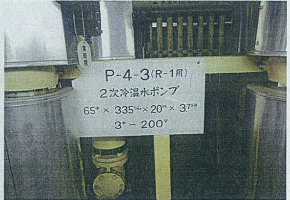
M 10 地下1階 P-4-3/2次冷温水ポンプ形式 10年程度の停止状態の為、機能停止又は著しい機能低下があると思われる 腐食もしくは錆の発生有 空調熱源設備 機械室
