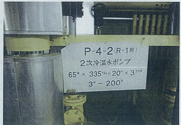
M 09 地下1階 P-4-2/2次冷温水ポンプ形式 10年程度の停止状態の為、機能停止又は著しい機能低下があると思われる 腐食もしくは錆の発生有 空調熱源設備 機械室
