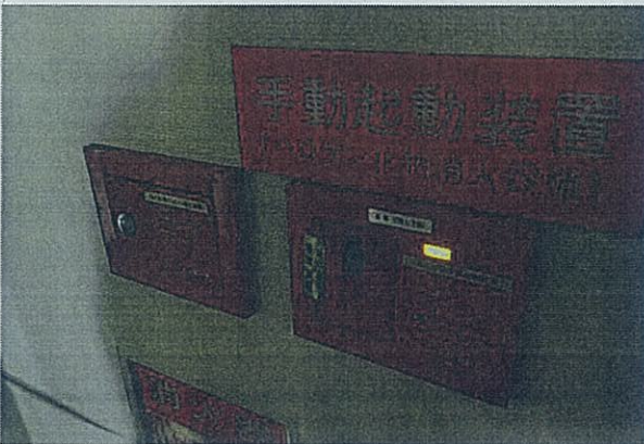
M 21 2階 ハロゲン消火設備起動装置
