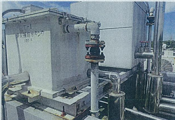
M 18 屋上階 T-1/消火補給水タンク外景 消火設備 腐食もしくは錆の発生有 設備置場
