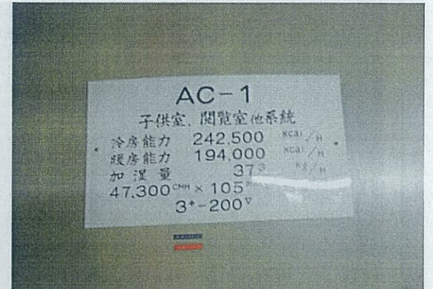
M 15 地下1階 AC-1/エアハンドリングユニット形式 空調設備 機械室
