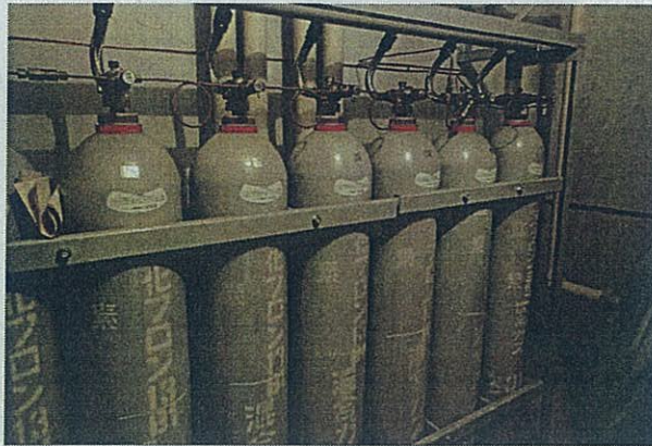
M 23 1階 消火フロンポンベ設置状況 消火設備 ポンベ庫
