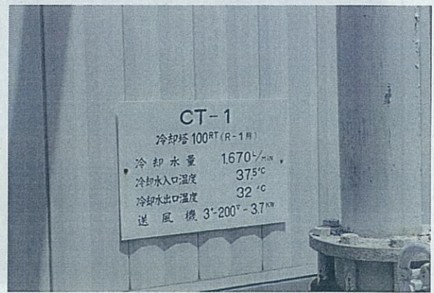
M 04 2階屋上階 空調熱源設備 クーリングタワー置場 CT-1/冷却塔形式 10年程度の停止状態の為、機能停止又は著しい機能低下があると思われる 腐食もしくは錆の発生有
