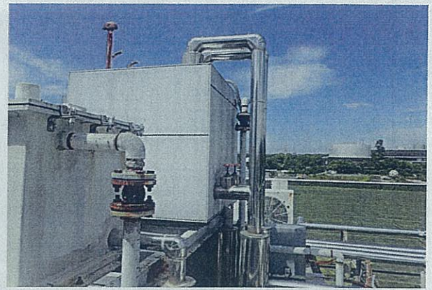
M 01 屋上階 膨張タンク接続配管 10年程度の停止状態の為、機能停止又は著しい機能低下があると思われる 腐食もしくは錆の発生有 空調熱源設備
