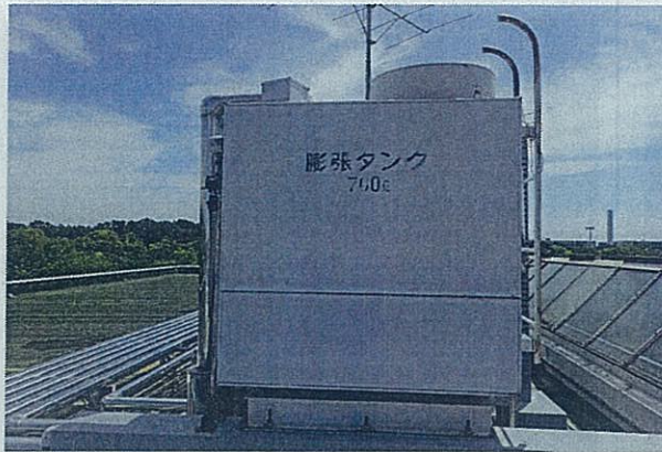
M 01 屋上階 膨張タンク外景 10年程度の停止状態の為、機能停止又は著しい機能低下があると思われる 腐食もしくは錆の発生有 空調熱源設備
