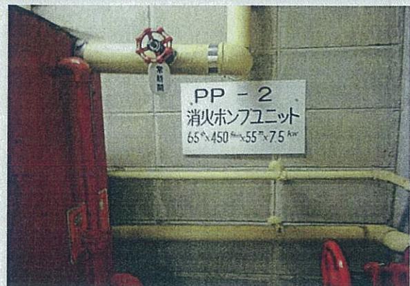
M 24 地下1階 PP-2/消火ポンプユニット形式 消火設備 消防点検記録より「テスト弁」標識無し 発電機室 の指摘有
