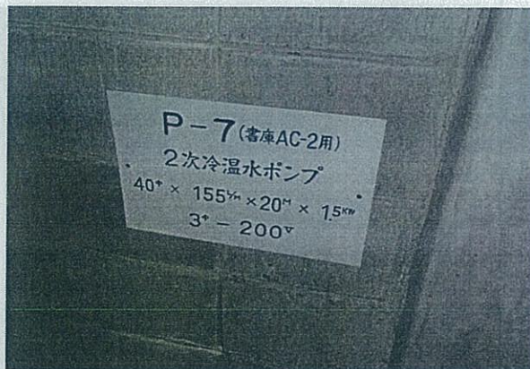
M 12 地下1階 P-7/2次冷温水ポンプ形式 10年程度の停止状態の為、機能停止又は著しい機能低下があると思われる腐食もしくは錆の発生有 空調熱源設備 機械室
