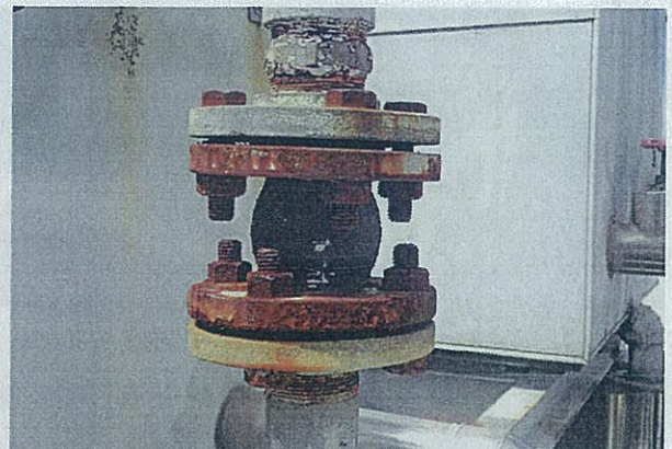
M 18 屋上階 T-1/消火補給タンク接続配管 消火設備 腐食もしくは錆の発生有 設備置場
