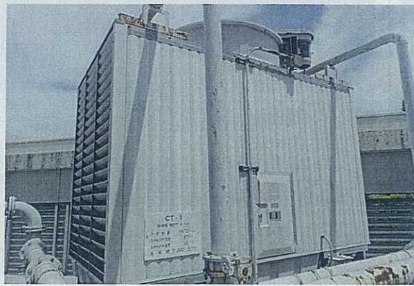
M 04 2階屋上階 空調熱源設備 クーリングタワー置場 CT-1/冷却塔外景 10年程度の停止状態の為、機能停止又は著しい機能低下があると思われる 腐食もしくは錆の発生有
