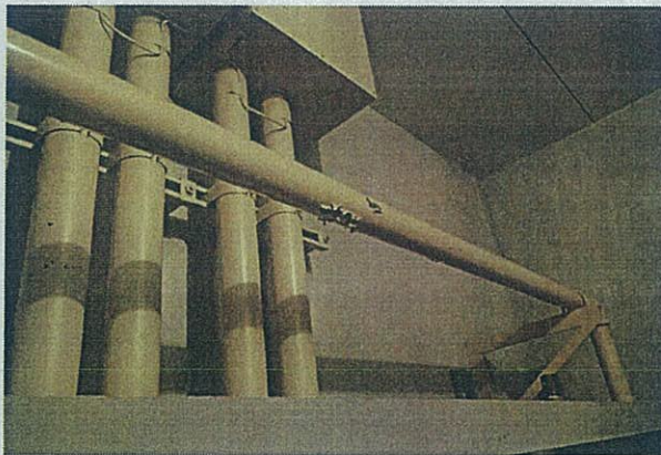
M 23 1階 消火フロンポンベ接続配管塗装剥れ 消火設備 ポンベ庫
