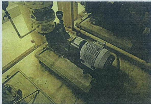
M 10 地下1階 P-4-3/2次冷温水ポンプ外形 10年程度の停止状態の為、機能停止又は著しい機能低下があると思われる 腐食もしくは錆の発生有 空調熱源設備 機械室
