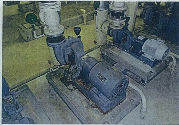
M 12 地下1階 P-6,7/2次冷温水ポンプ外景 10年程度の停止状態の為、機能停止又は著しい機能低下があると思われる腐食もしくは錆の発生有 空調熱源設備 機械室
