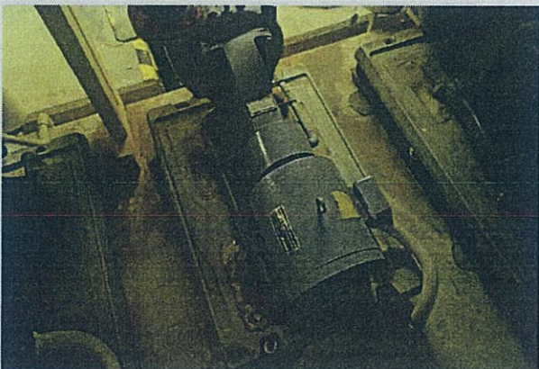
M 08 地下1階 P-4-1/2次冷温水ポンプ 空調熱源設備 10年程度の停止状態の為、機能停止又は著しい機能低下があると思われる 機械室 腐食もしくは錆の発生有
