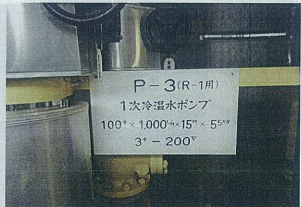
M 07 地下1階 P-3/1次冷温水ポンプ形式 空調熱源設備 10年程度の停止状態の為、機能停止又は著しい機能低下があると思われる 機械室 腐食もしくは錆の発生有
