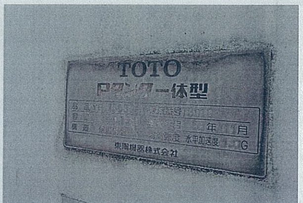
M 18 屋上階 T-1/消火補給タンク製造銘板 消火設備 腐食もしくは錆の発生有 設備置場
