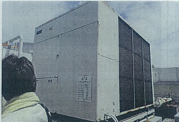
M 02 2階屋上階 R-2/冷温水発生機外景 10年程度の停止状態の為、機能停止又は著しい機能低下があると思われる 腐食もしくは錆の発生有 空調熱源設備 クーリングタワー置場
