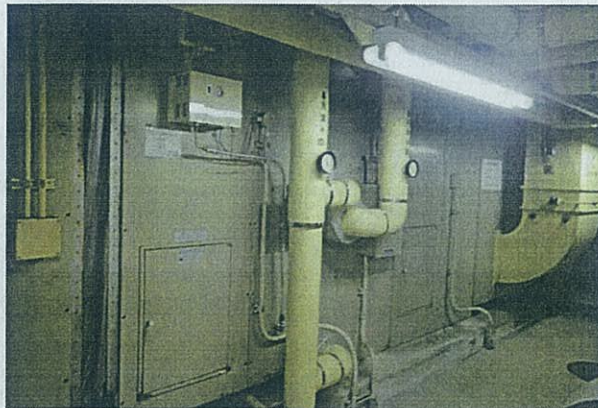
M 15 地下1階 AC-1/エアハンドリングユニット(全熱交換機組込)外景 空調設備 機械室
