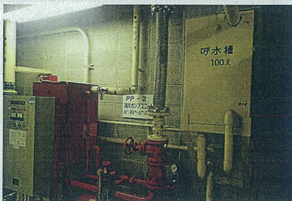
M 24 地下1階 PP-2/消火ポンプユニット外景 消火設備 消防点検記録より「テスト弁」標識無し 発電機室 の指摘有
