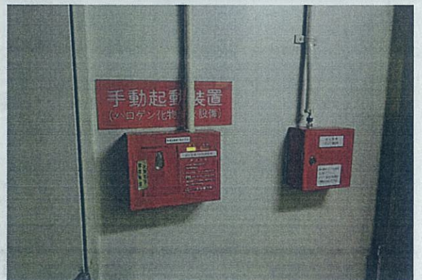
M 22 1階 ハロゲン消火設備起動装置
