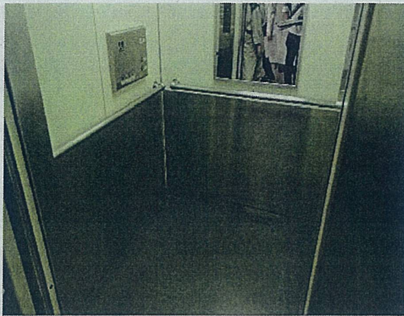
E 01 1階 昇降かご 内観 昇降機設備 戸開走行保護装置および遮煙扉未設定の為、既存不適格となっている EVホール
